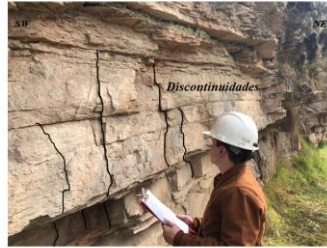
Figura 10. Levantamiento de discontinuidades.
