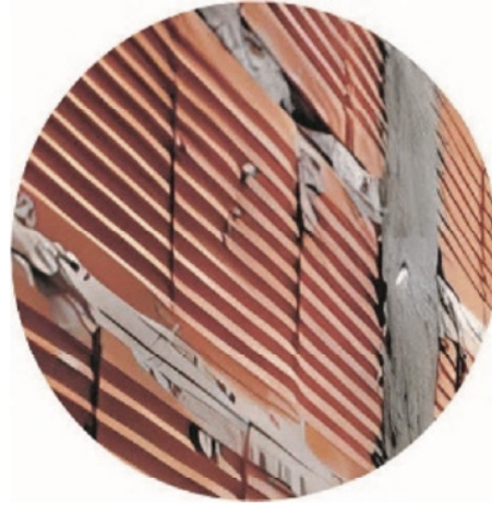
Figura 1. Sistemas constructivos de mampostería con bloques cerámicos.
