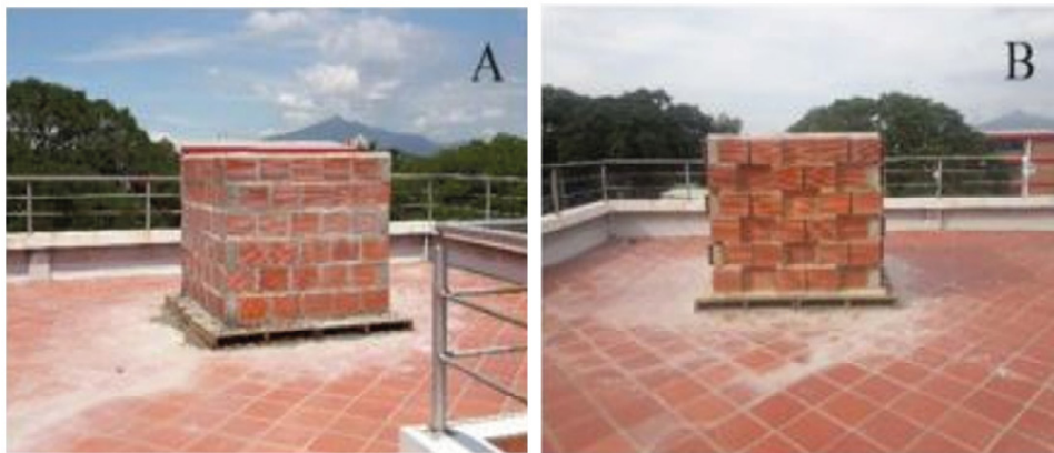
Figura 9. Construcción de los módulos A y B.
