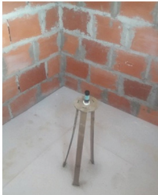
Figura 13. Equipo instalado para medir condiciones interiores ambientales en Módulo A y B.
